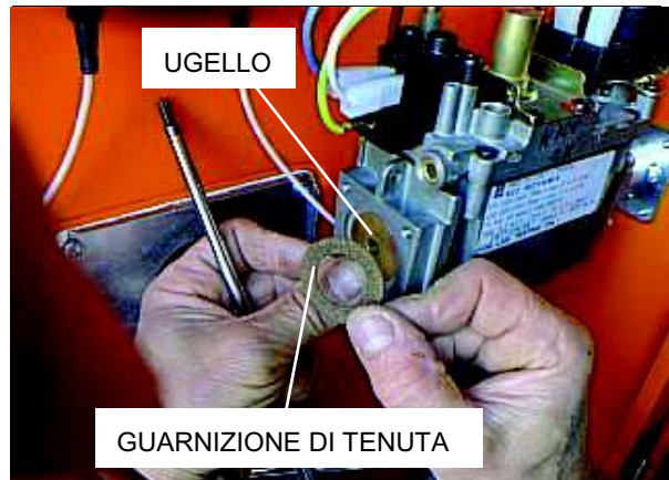
Figura 29 – Sostituzione ugello
