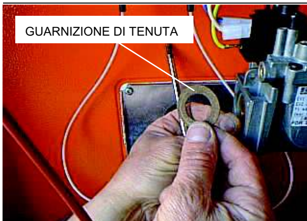
Figura 28 – Guarnizione di tenuta
